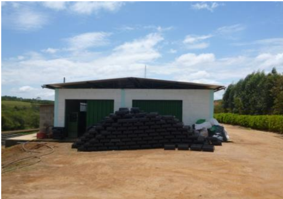
Figura 30- Vista geral do galpão de produção no viveiro da GOS Florestal em Conselheiro Lafaiete - MG
